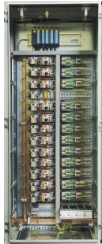
Panel modular (vista interior)
