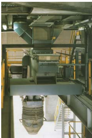
Tromba com carro móvel de fundo fluidizado.
