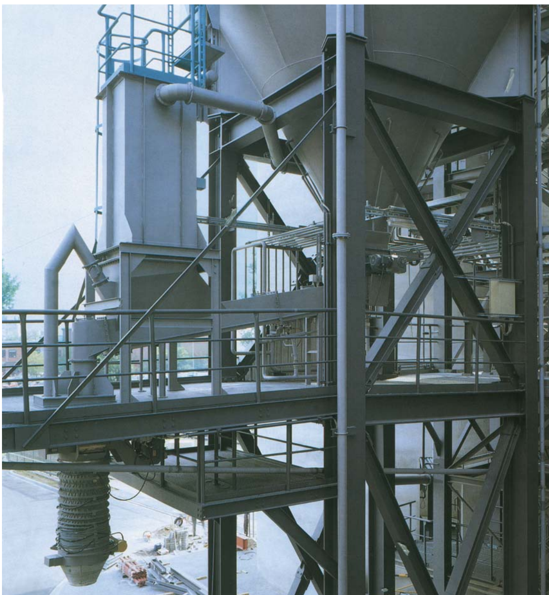
Instalação típica de uma tromba de carregamento fixa com sistema de dosagem e desempoeiramento
